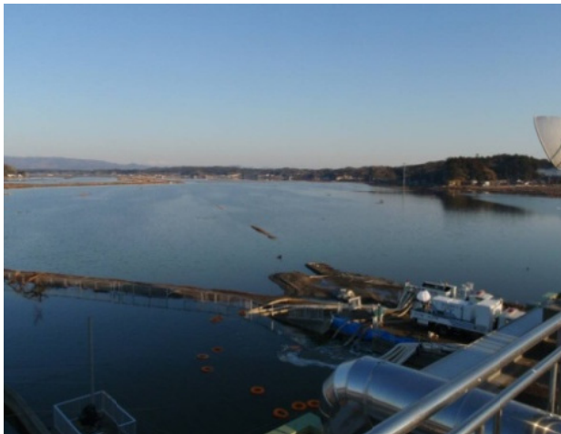
(排水の作業前)
