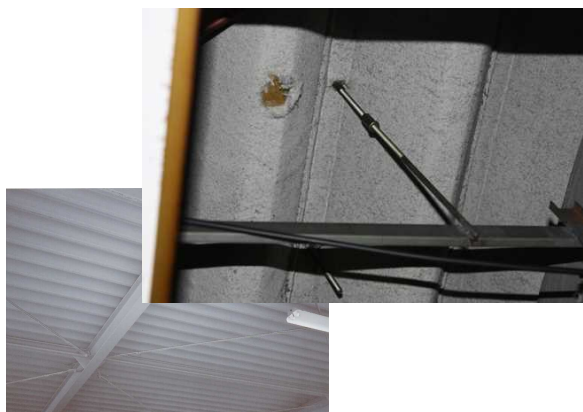
レベル 2: 屋根用折板石綿断熱材
